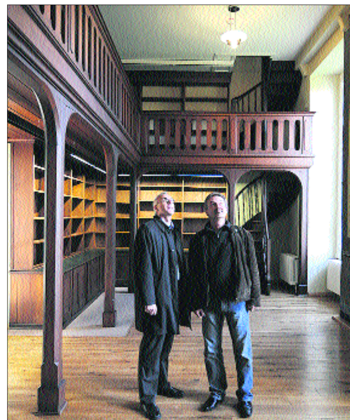
In der Bibliothek: Rainer Bolli (links), Leiter des Gebäudemanagements der Universität, und Projektleiter Robert Förster begutachten das Ergebnis der Sanierung.
